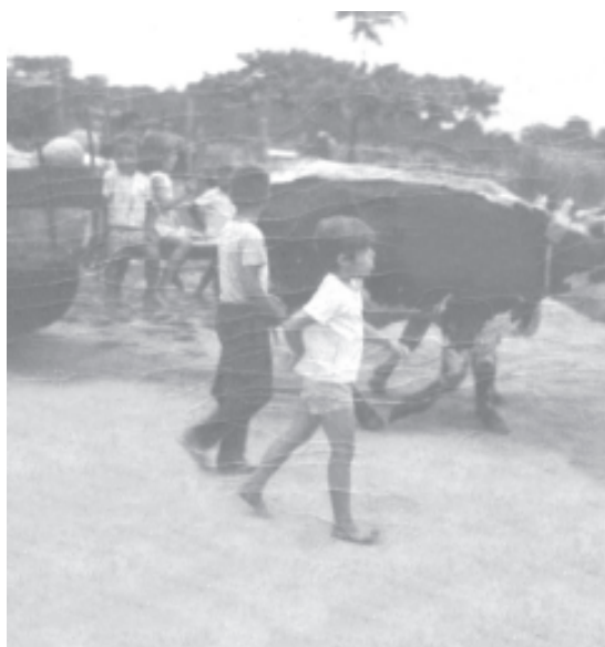
Carros de boi transportando pedras e areia para baldrame do Lar dos Velinhos, terreno já aterrado para construção.1963.
