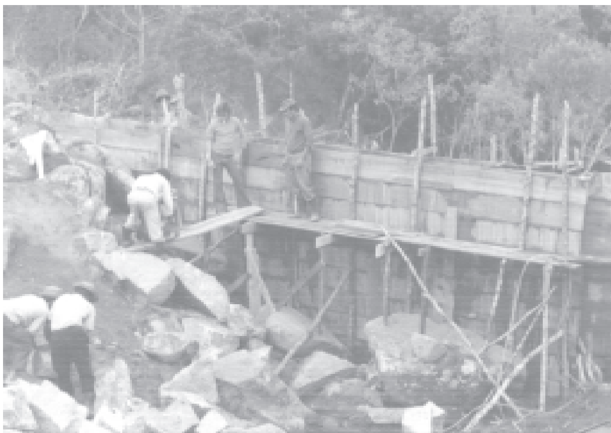
A represa em construção.
