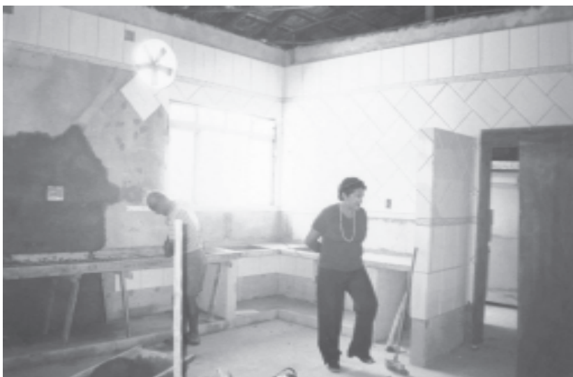
Reforma da cozinha do Lar dos Velhinhos. Vistoria da Administradora Maria Sonia Pelegrin Warken.2002.
