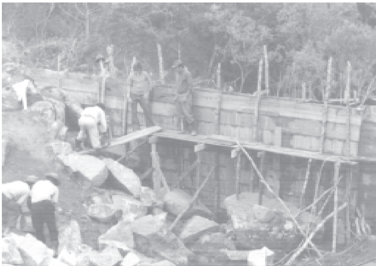
A represa em construção.
